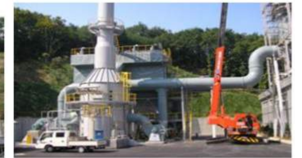
한국건설기술연구원 BAG FILTER, SCREUBBER
